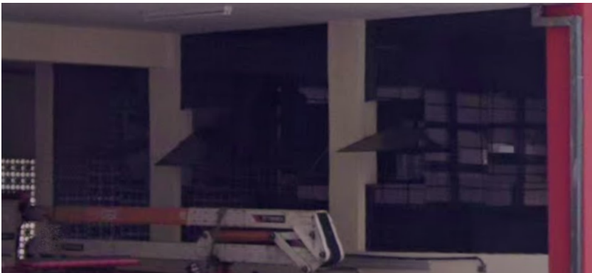
Imagem 02 - vidros da parte interna da prontidão
